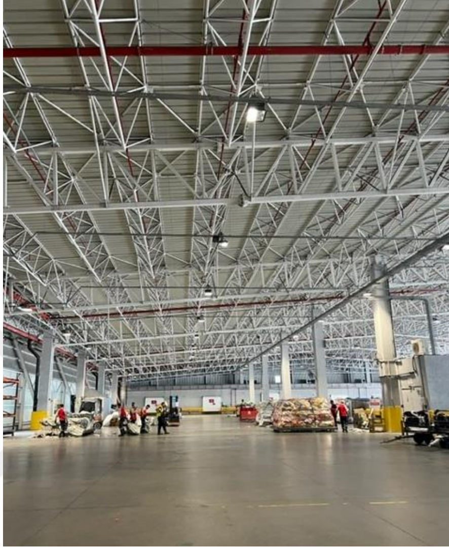
Şekil 3.1: Çalışma Yapılan İşletmeye Ait Genel Görünüm
